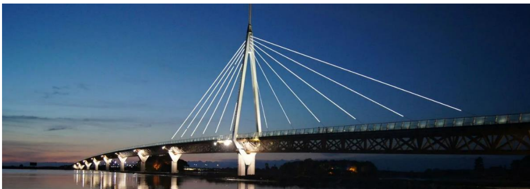
Рис.3.Город Анаклия. Мост через реку Ингури
