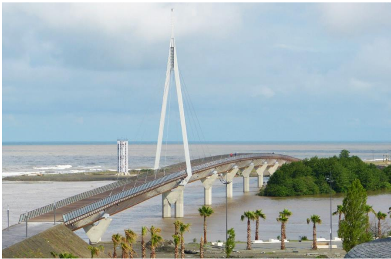
Рис. 2. Город Анаклия. Мост через реку Ингури
