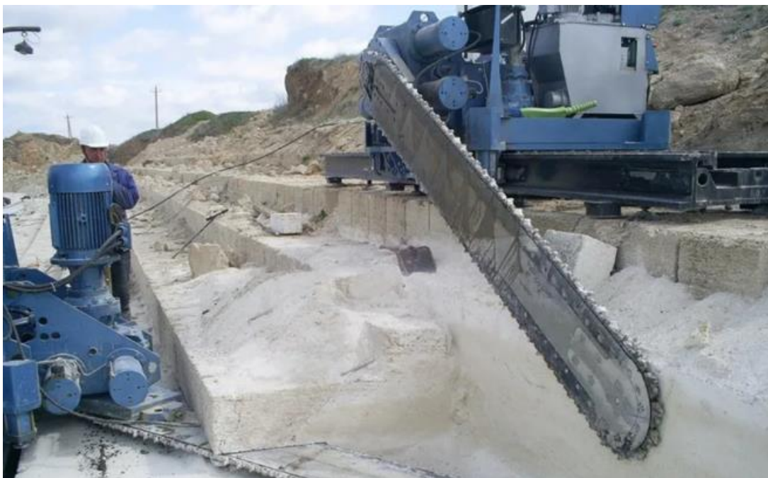
Рис.1. Разрезка каменной породы механическими пилами
