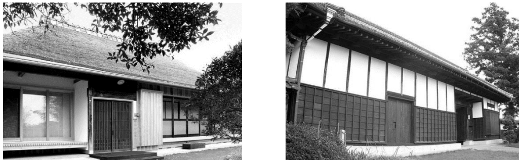
Рис. 4 – выступающие карнизы и видимый каркас здания
