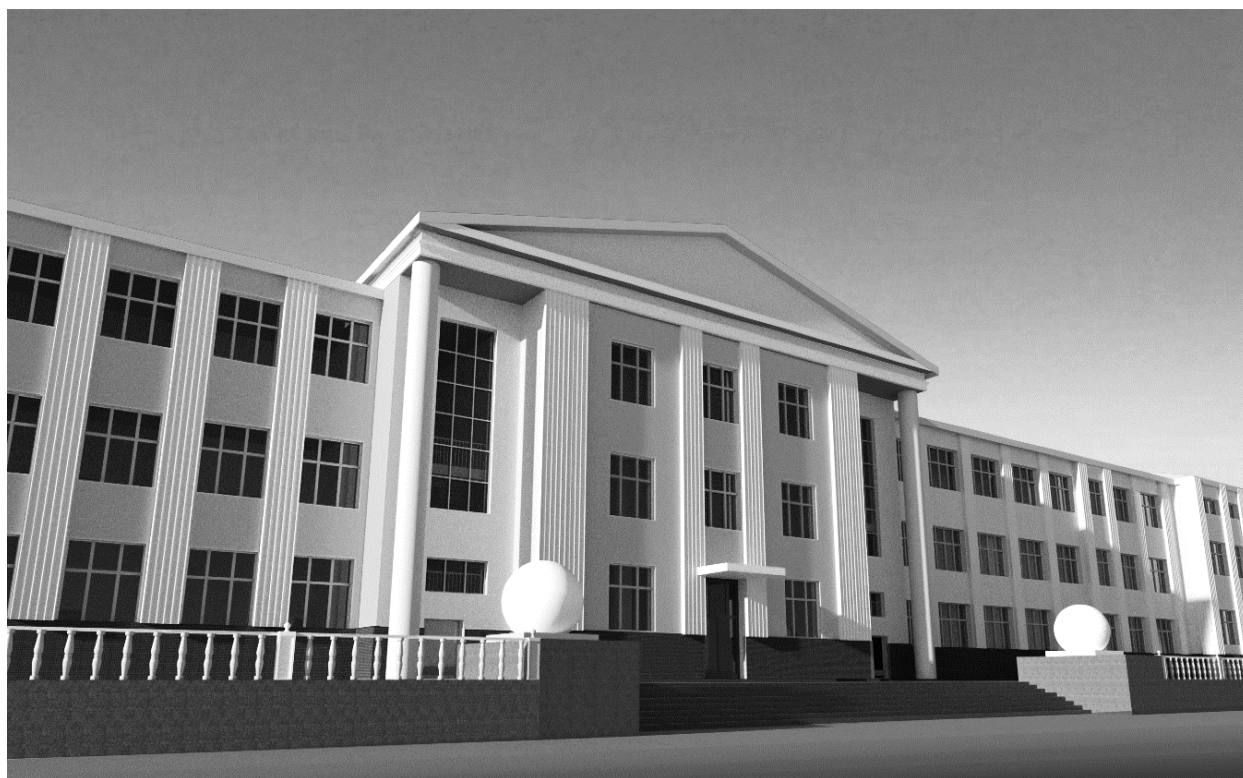
Рис. 2. Визуализация модели ГУЗа, созданной по облаку точек в Revit Architecture
