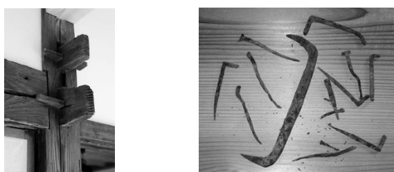
Рис.3 – деревянные и металлические крепления
